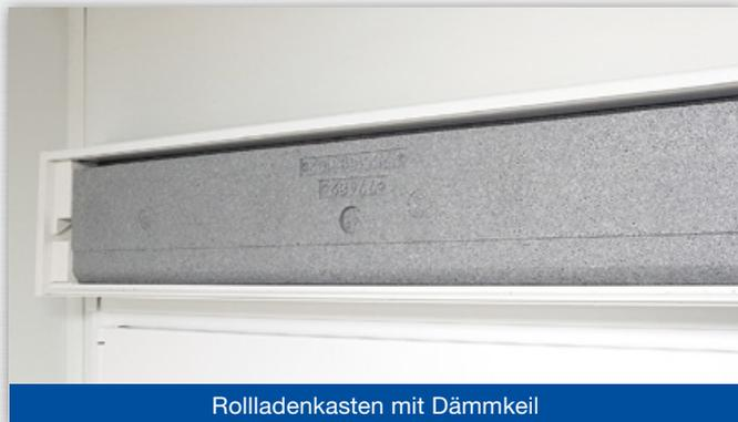
Rollladenkasten mit Dämmkeil
